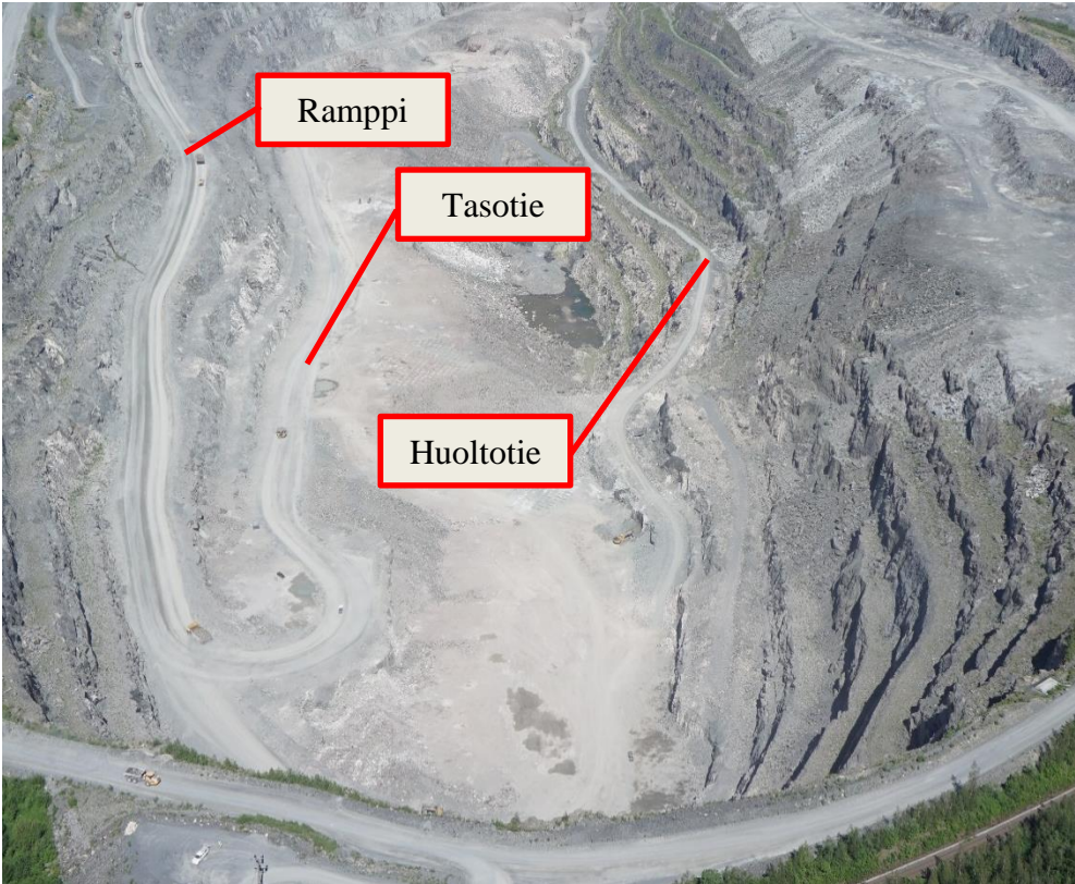
Kuva 2. Louhoksessa olevat tietyypit.
