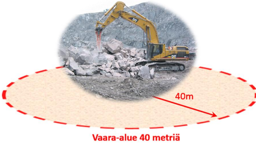
Kuva 4. Käynnissä oleva rikotustyö ja sen vaara-alue.
