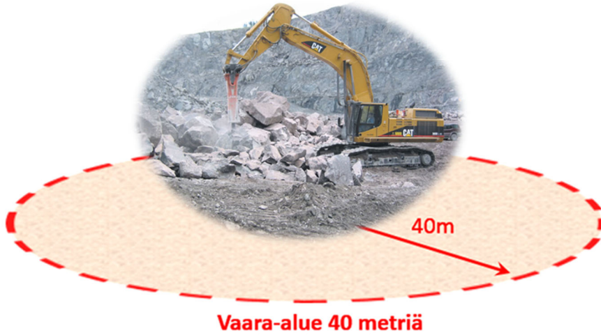
Kuva 4. Käynnissä oleva rikotustyö ja sen vaara-alue.
